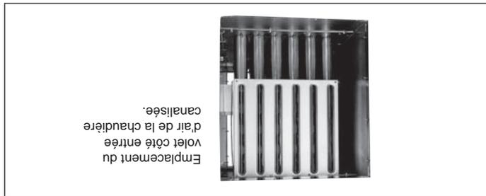
**Remarque sur l'inversion de la circulation d'air :** Si des options de ventilation (thermostat, protection anti-gel, etc.) ont été installées, ces options devront être déplacées côté sortie d'air de la chaudière canalisée.
